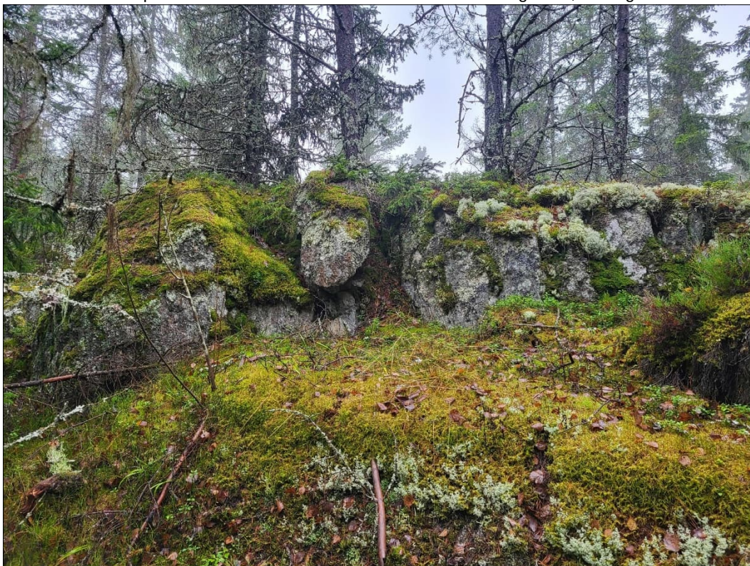
Figur 4-9 Stort löst block i bergslänt.
