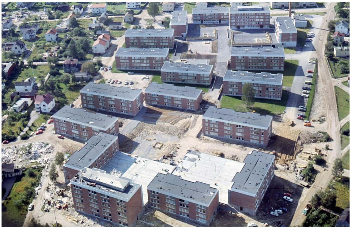
Foto från 1960-talet över byggnationen av norra delen av område 1.5.
