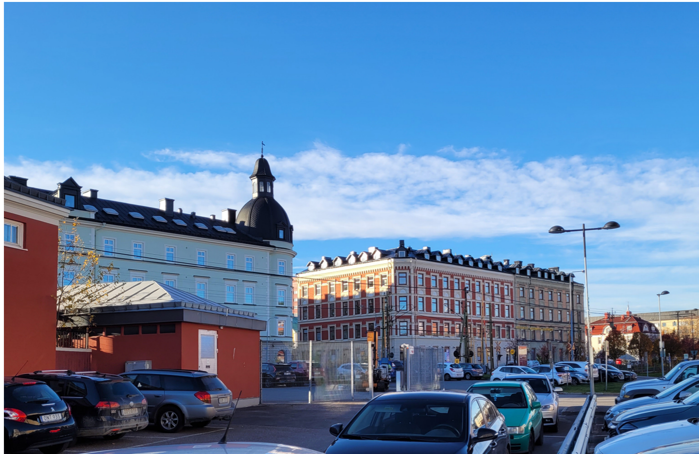
Fronten sett från gasverkstomten.
