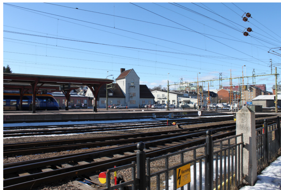
Stationsområdet vy mot sydväst mot expeditionshuset/pumphuset och lokstallet. Foto Tyréns, mars 2021.
