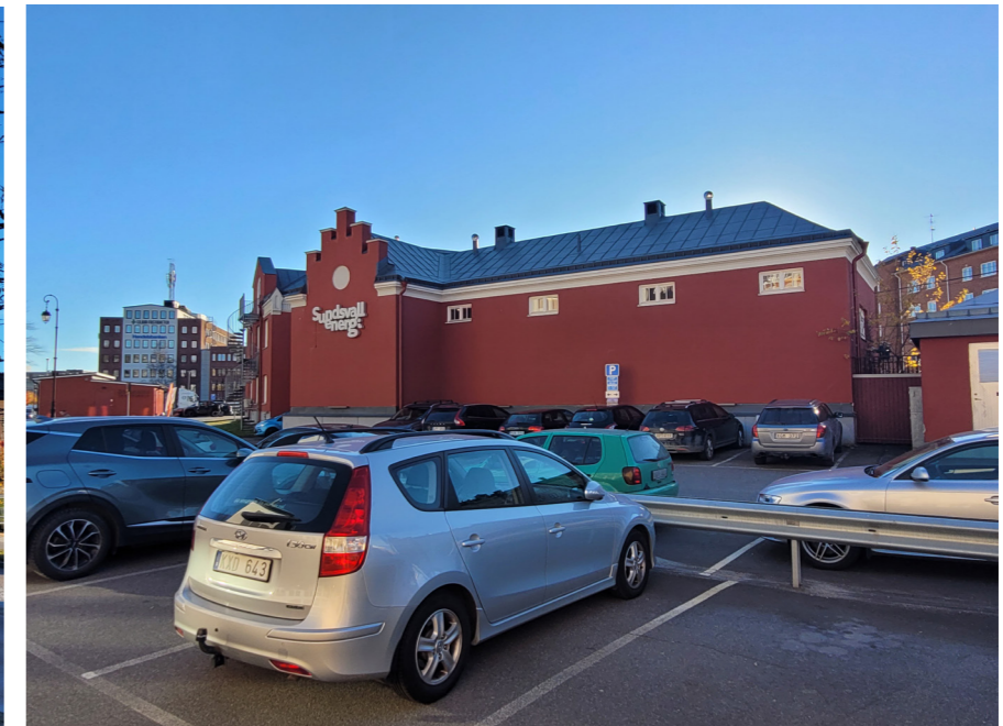
Nisse och Hallströms hus sett från gasverkstomtens västra sida. Foto 2024.
