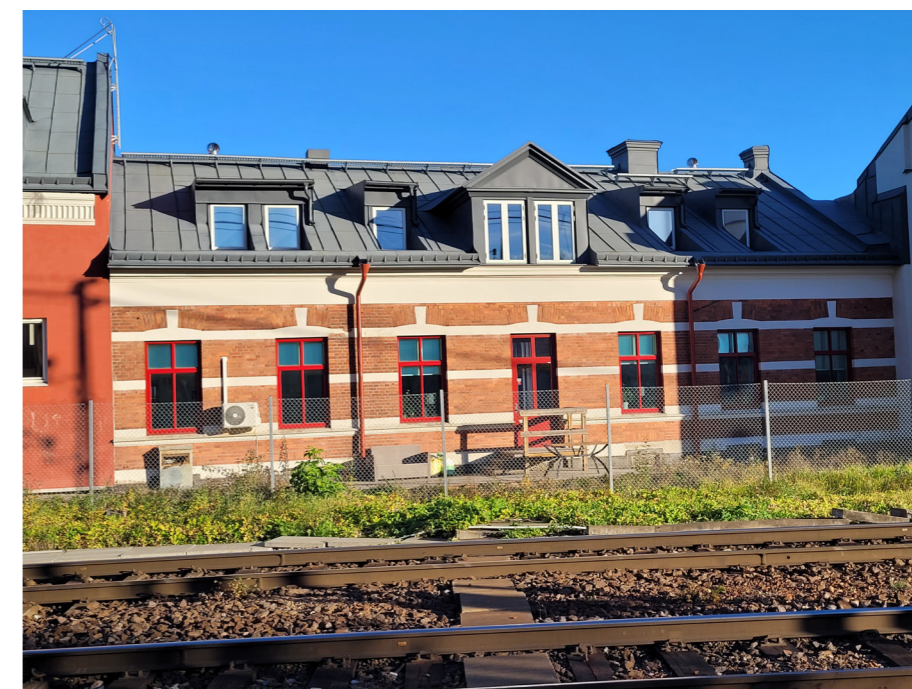
Förvaltningshusets fasad mot söder och järnvägsspåren.
