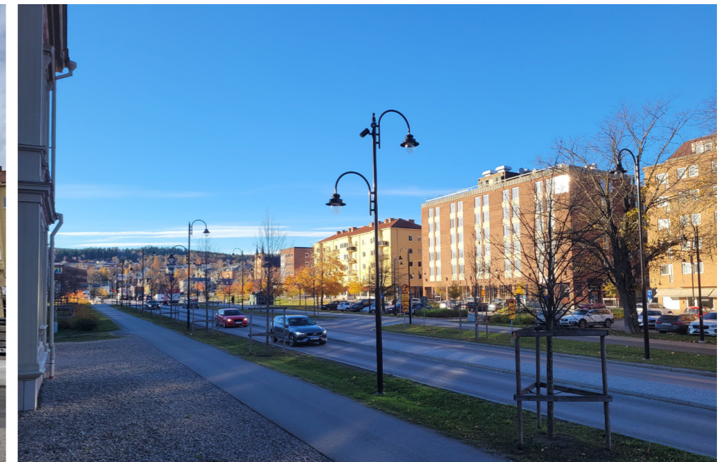
Fronten sett från gamla järnvägsstationen.
