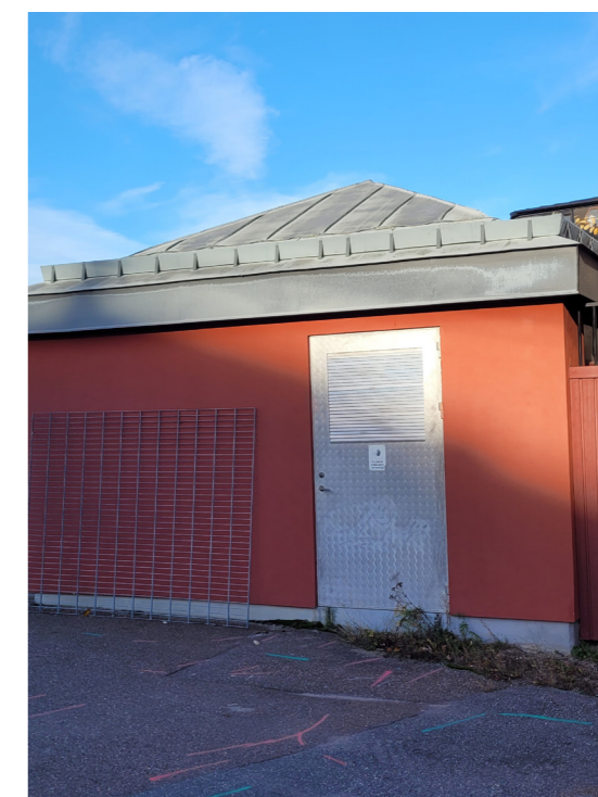
Taket är valmat med plåttäckning.
