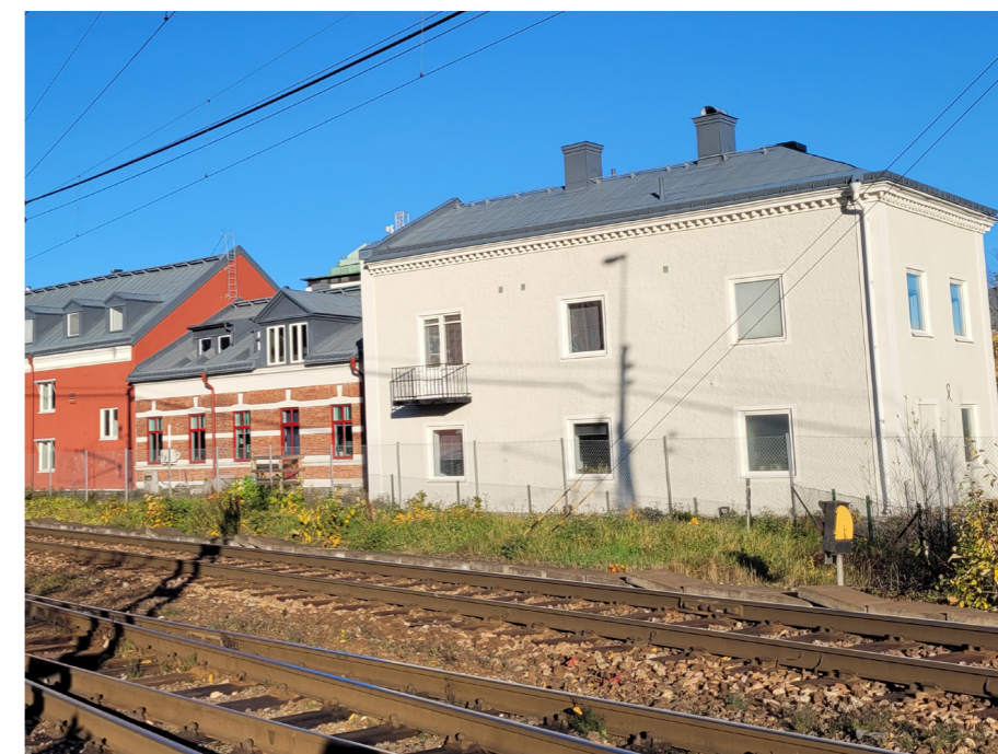
Fasad mot söder och järnvägsspåren.
