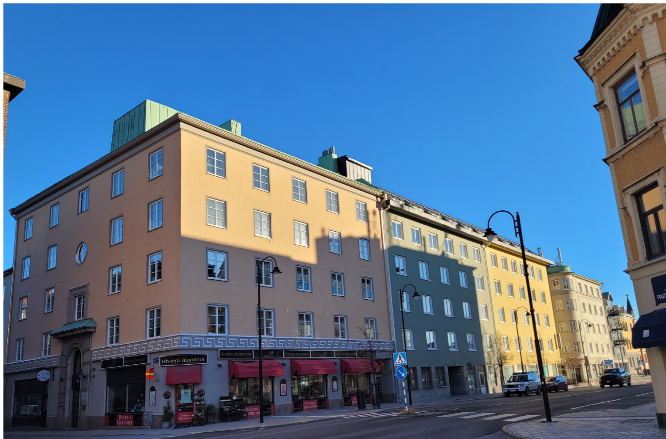
Fronten sett från korsningen Nybrogatan-Köpmangatan.
