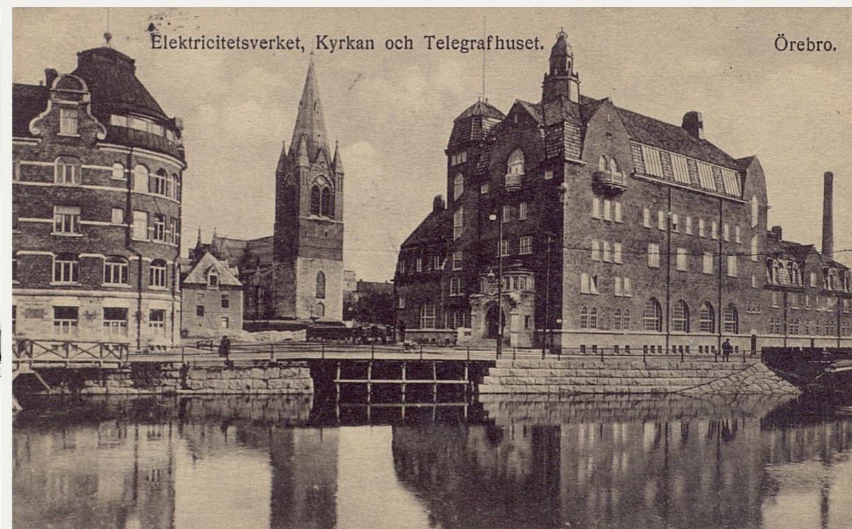
Örebro elektricitetsverk till vänster. Övriga byggnader i bilden är Sankt Nikolai kyrka och telegrafhuset (Tekniska museet).
