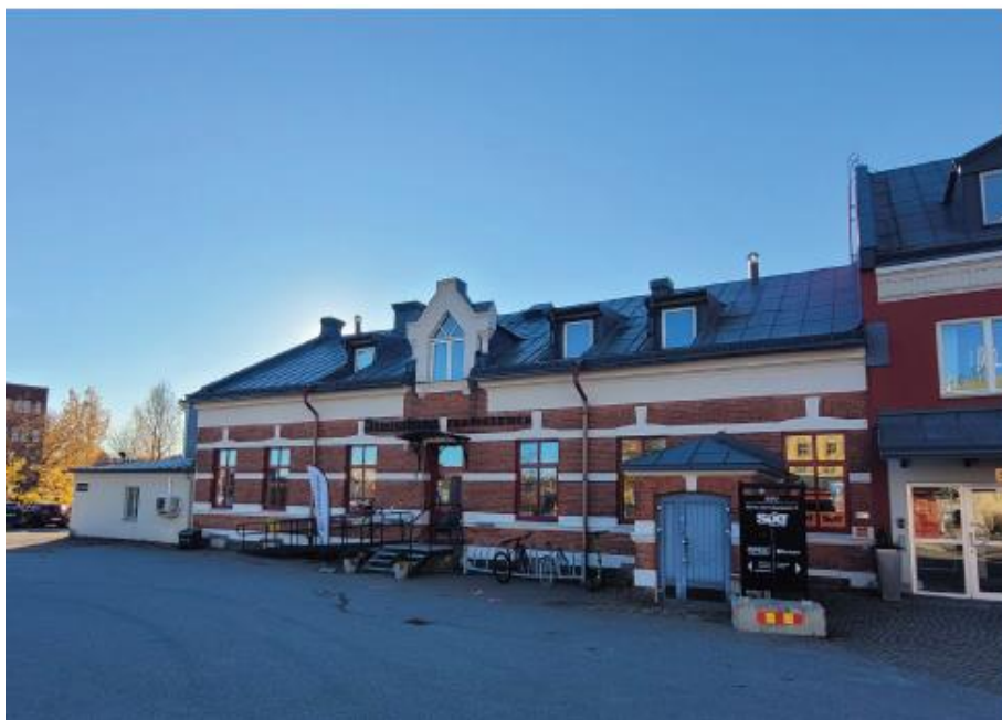
Förvaltningshuset fasad mot gården. Kulturmiljöutredning, Tyrens, 2025-04-03.
