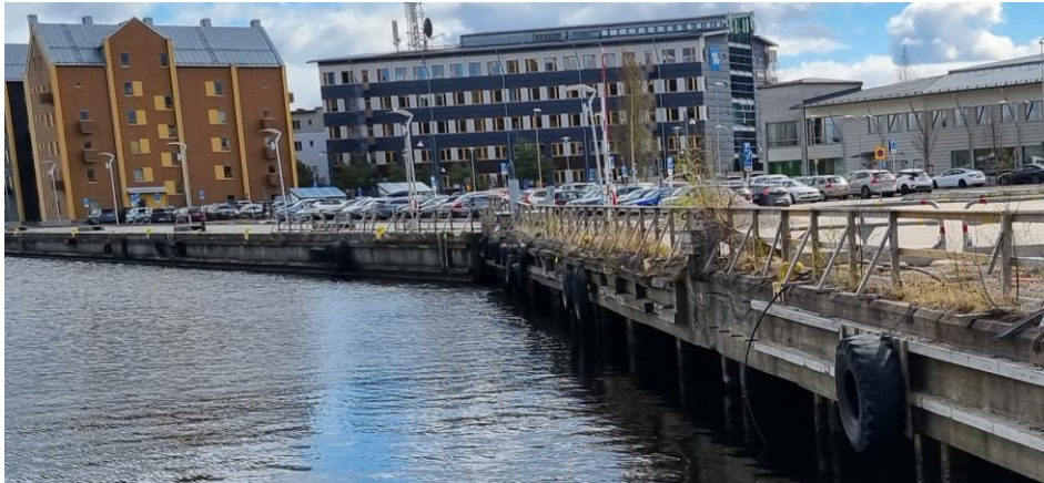
Figur 3, Foto som visar att kajens frontmur nu har en betongyta.
