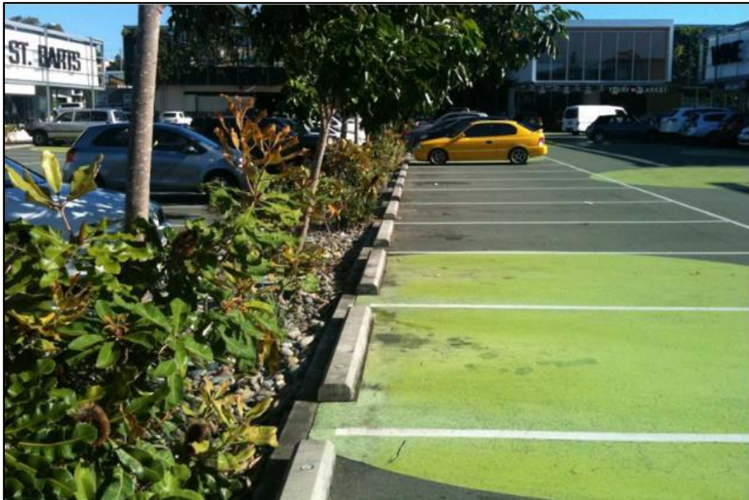
Figur 6-10. Öppning i kantsten, inlopp växtbäddar (Waterbydesign, 2014).
