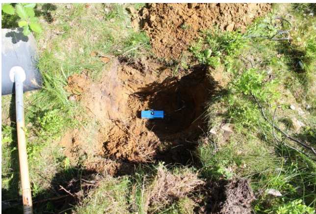
Bild 2. Treriktningsgivare, före jordtäckning.
