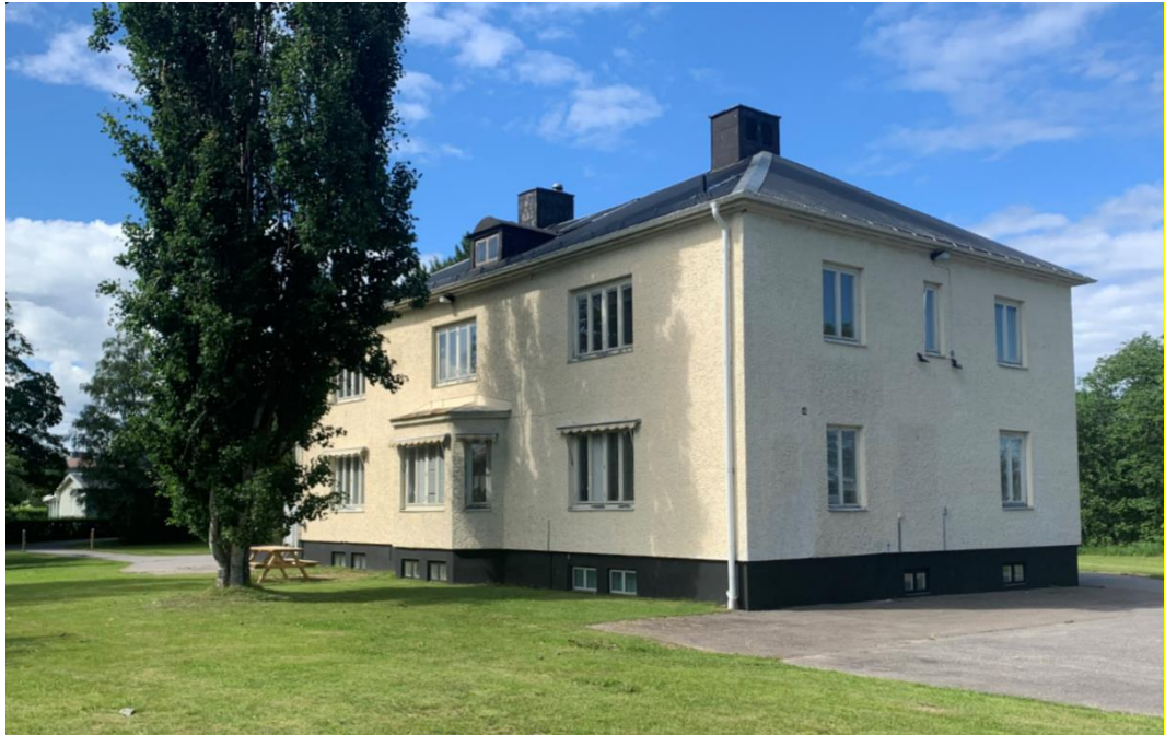
Figur 2. Södra och östra fasaden på den fd. pastorexpeditionen (Prästgården), nu kontorsbyggnaden, på fastigheten Njurunda Prästbol 1:124 (Källa: Järnvägen Fastigheter AB)
